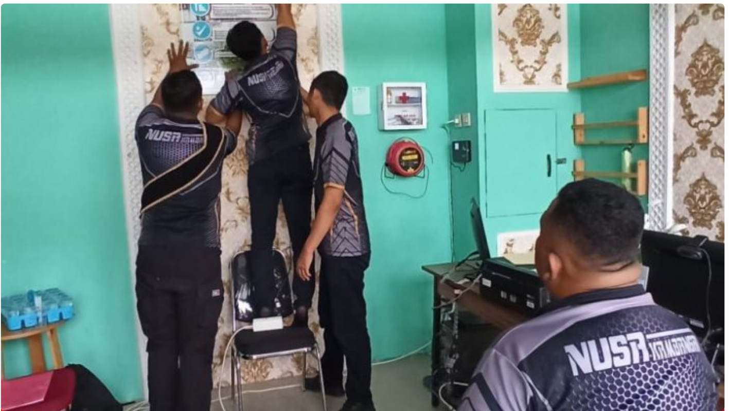
Kabapas dan Staff Renovasi Ruang Baladewa
